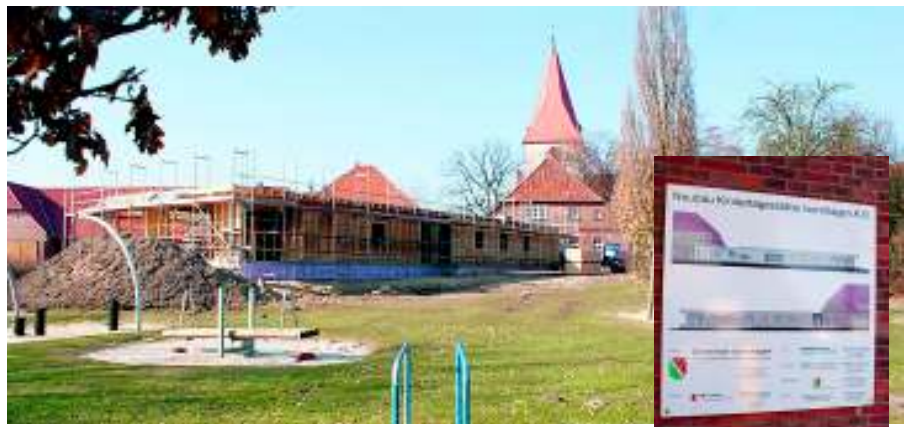
Es geht voran mit dem neuen Kindergarten in Isernhagen K.B. Trotz Winter sind die Bauarbeiten gut fortgeschritten.
